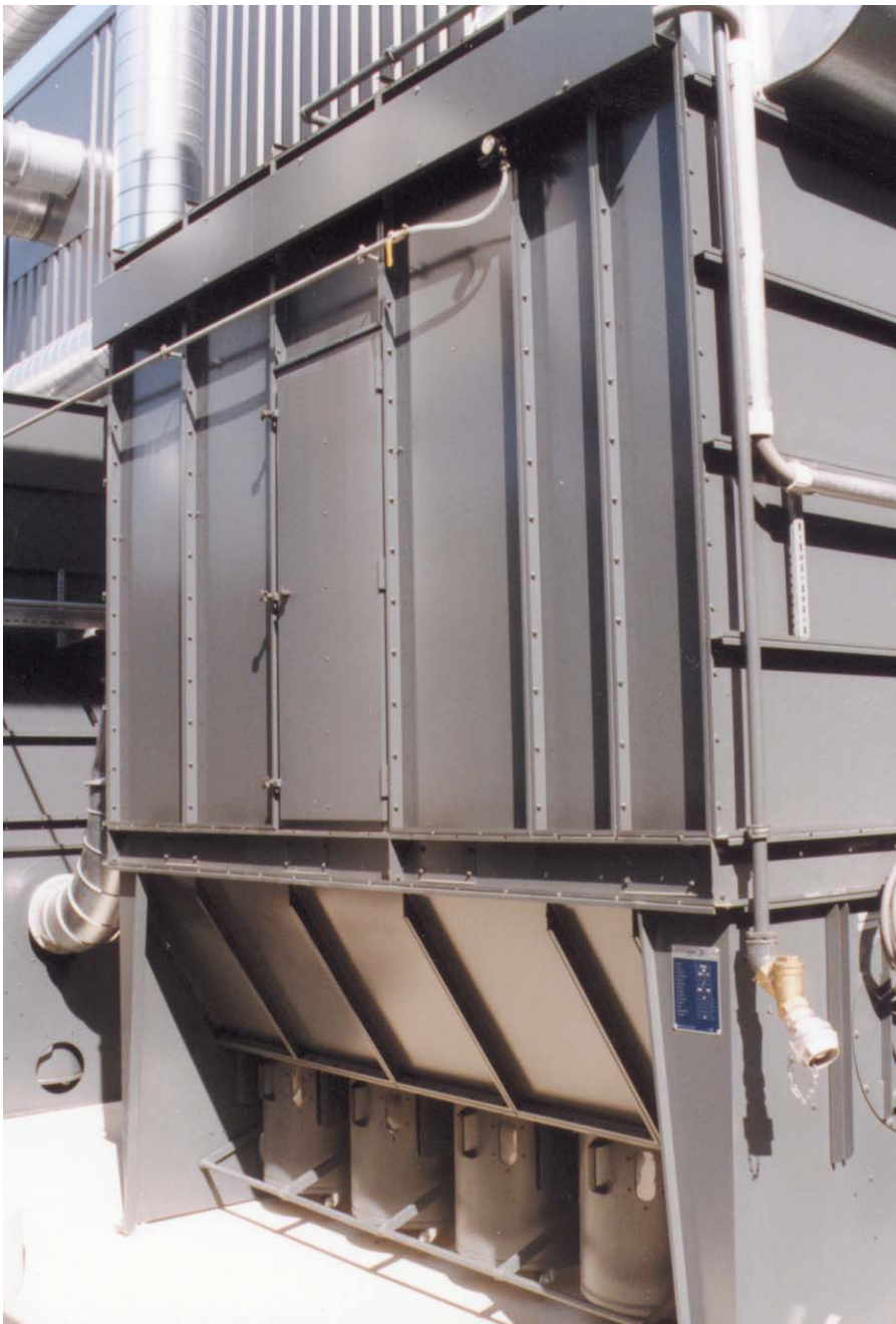
Absackfilter mit reinluftseitig integriertem Ventilator als Unterdruck-Filter.
